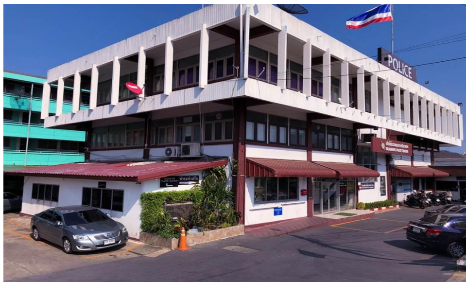
ภาพ อาคารสถานที่ ของสถานีตำรวจมีการดูแลรักษาความสะอาด
